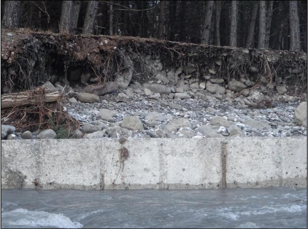
Où l'on retrouve, en amont du confluent avec le Guil, d'anciens ouvrages de protection des terrains, ici des éléments de béton formant mur. Le Chagne est passé bien au-dessus.
