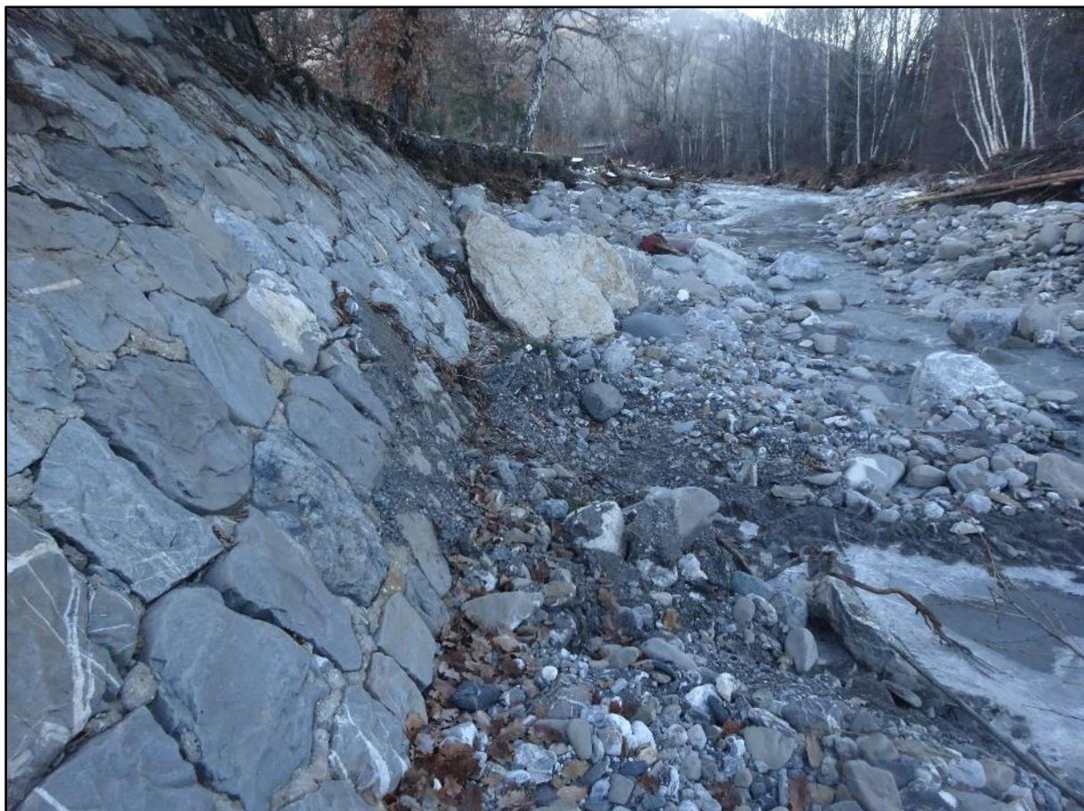
Le torrent est visible au fond. Il est passé au premier plan, mettant à découvert une ancienne digue dans le secteur des campings.
