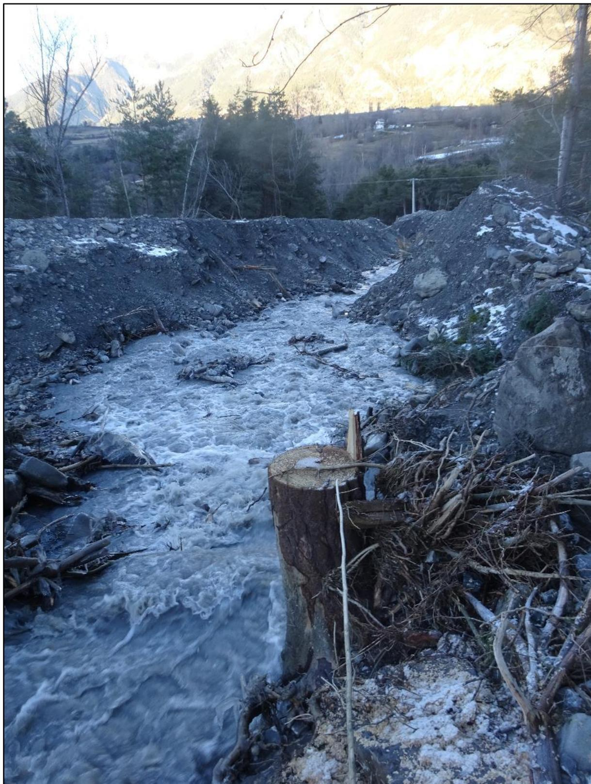
Qui dit cône de déjection dit pente plus faible et zone d'accumulation de dépôts d'alluvions. La réponse de l'homme est de creuser dans le tas pour l'évacuation rapide de l'eau en un passage unique.
