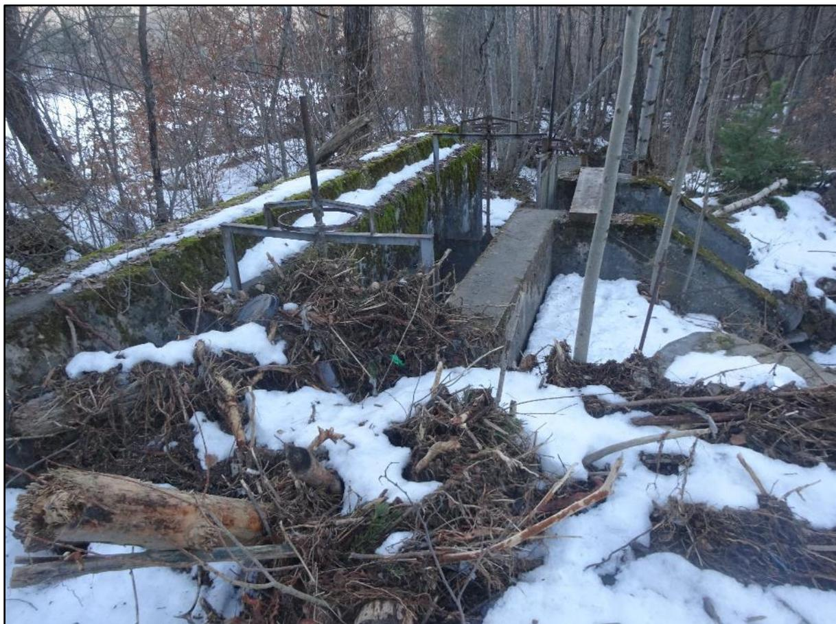
Sous le pont en rive gauche, un long mur de béton protégeant les champs et un canal parallèle arrivant à ces martelières.
