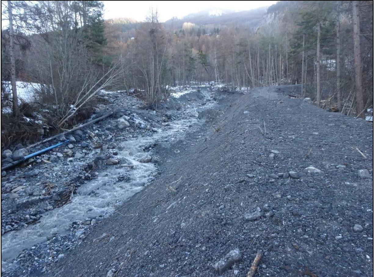
Il y a des tuyauteries de ci de là, un torrent bien curé et une belle digue qui va se terminer en amont en s'appuyant contre le piémont de la montagne. L'eau ne passera plus n'importe où, elle en rejoindra plus le Plan de Phazy.
