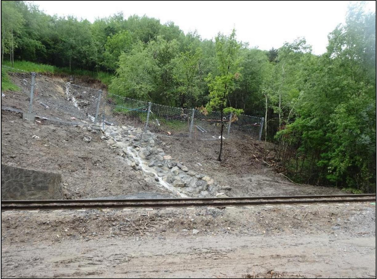
Les filets, qu'on place habituellement au bord des chaussées pour les protéger des chutes de blocs, accompagnent un enrochement du passage du torrent.
