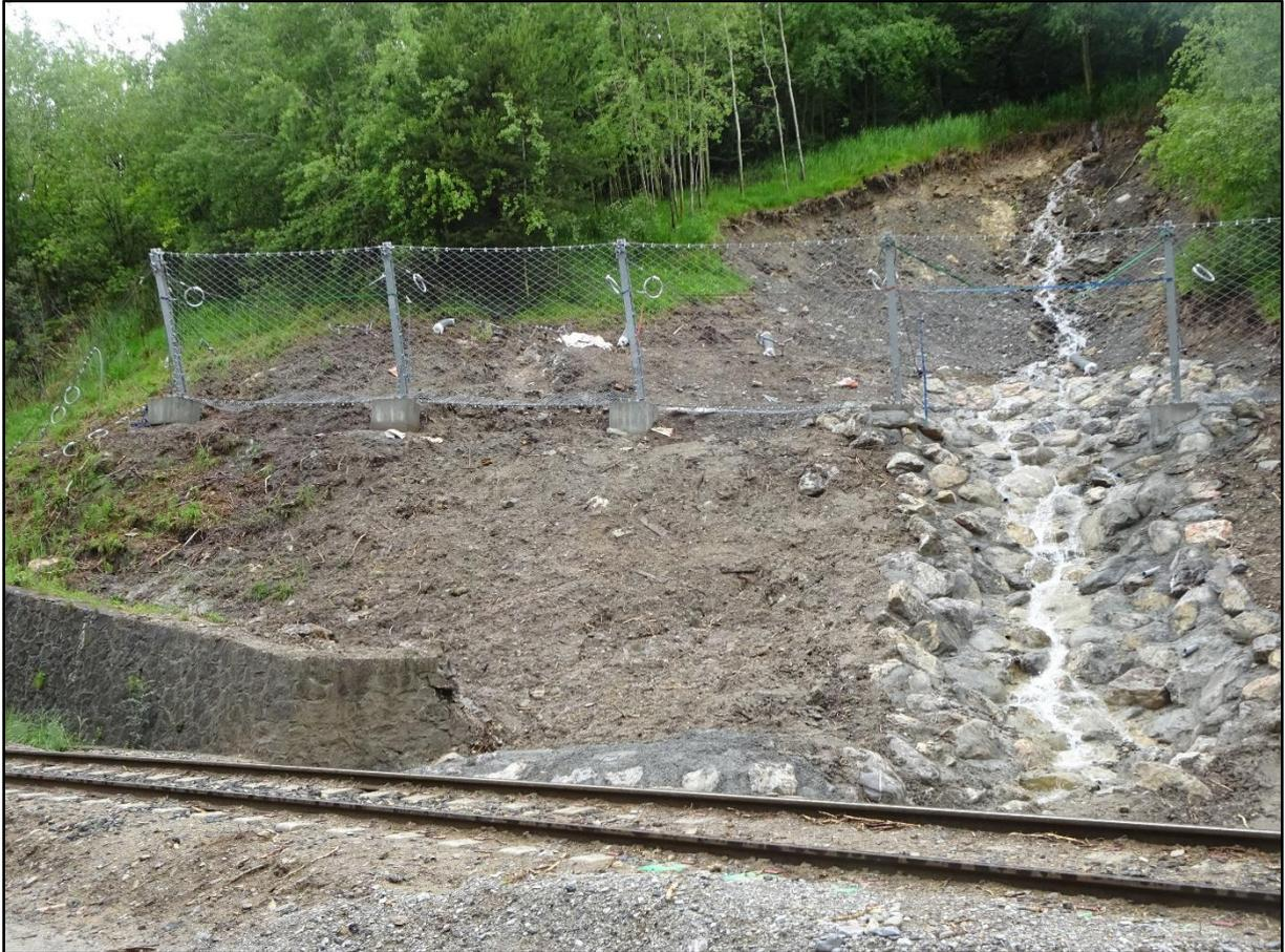
Les poteaux des filets sont arrimés dans de gros blocs de béton, au printemps prochain tout ce qui est en terre reverdira et les voyageurs n’y prêteront plus attention.
