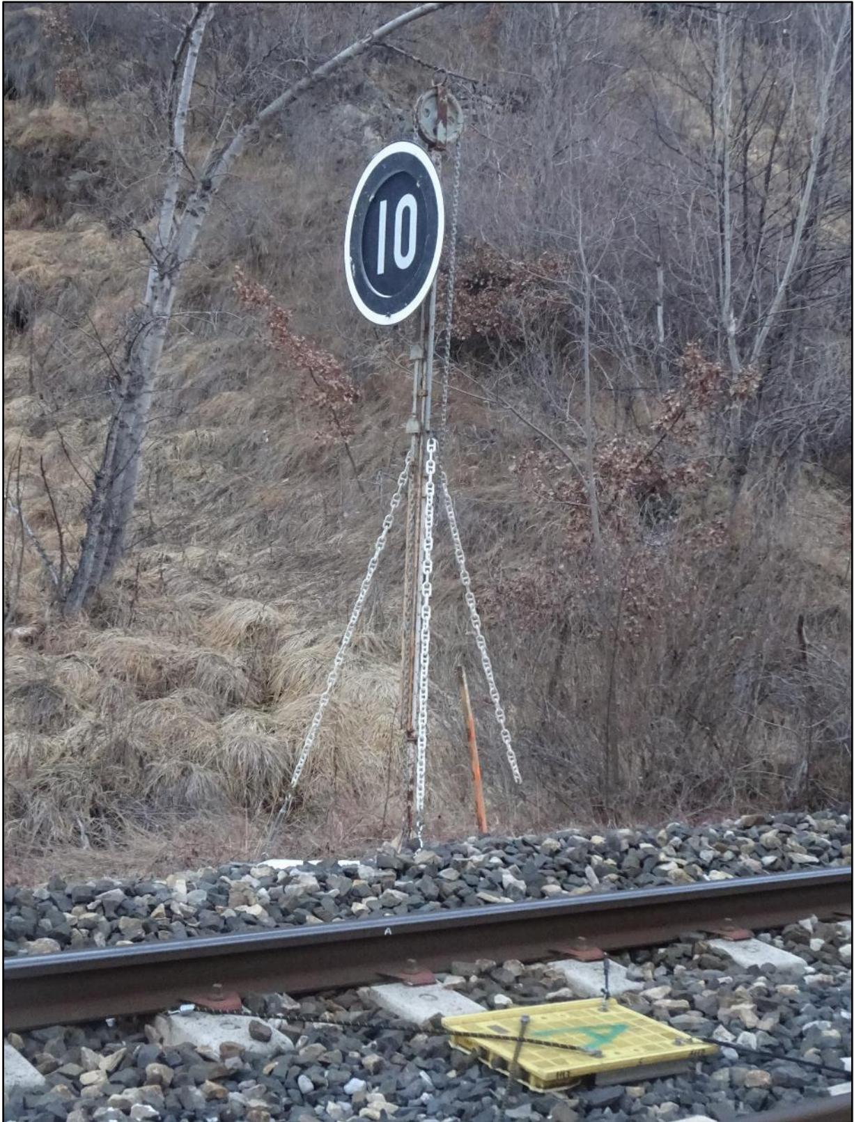
L'ensemble du dispositif, il y en a deux : un en amont, un autre en aval de la zone problématique.
